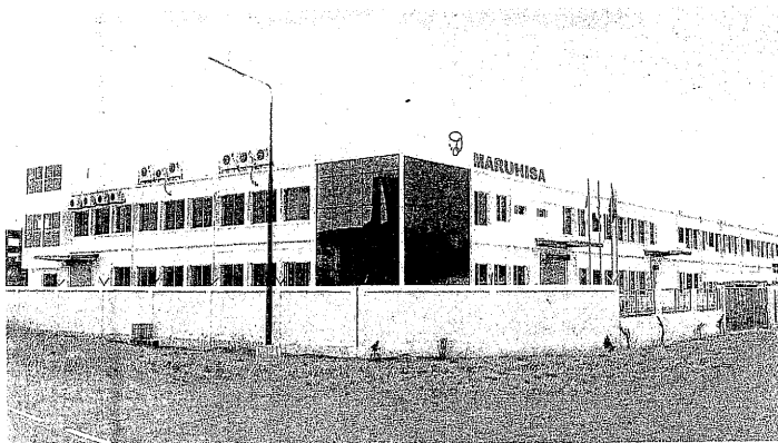
丸久がバングラデシュに構える縫製工場。10月稼働を目指して、隣接地に生地工場を建設している（同社提供）
